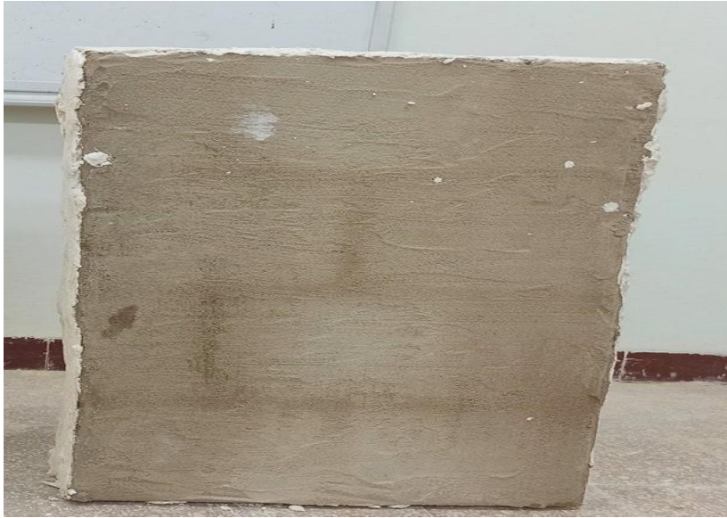
Figure III.3 : Mur en brique avec une plaque de mortier.
