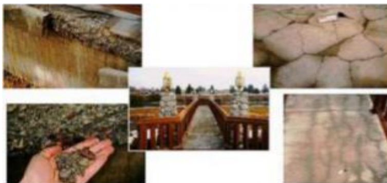
Désordres dus au cycle gel/dégel
