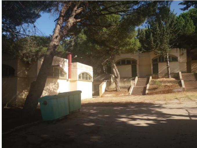
Figure 71: bungalows existants sur le terrain Source : auteur
