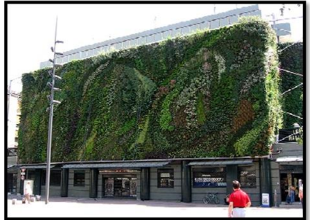
Figure 90: : Mur végétal des halles à Avignon (Place Pie). Source : www.commonswikimedia.org
