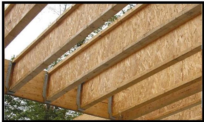
Figure 118: Une poutre en bois
