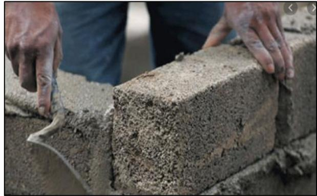
**Figure C22 :** mortier de ciment
