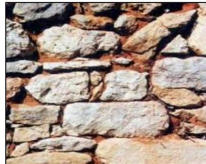
**Figure C20 :** mur en apreillage irrégulier
