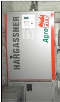
**Figure C 71 :** la chaudière biocombustible herbacé
