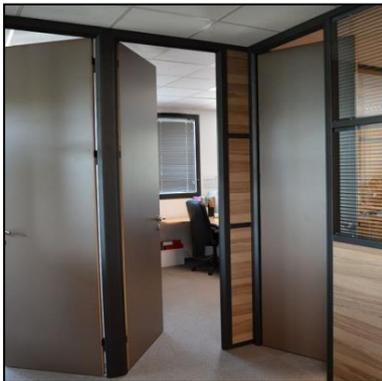
**Figure C 56 :** Portes battantes en aluminium
