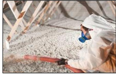
**Figure C 97 :** comment déposer la ouate de cellulose pour toiture.
