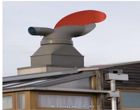
**Figure C 78** : capot rotatif en acier inoxydable
