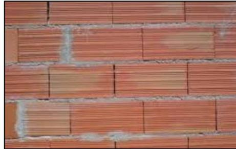
**Figure C19 :** mur en brique creuse
