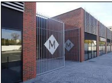
**Figure C 59 :** Portes battantes en aluminium
