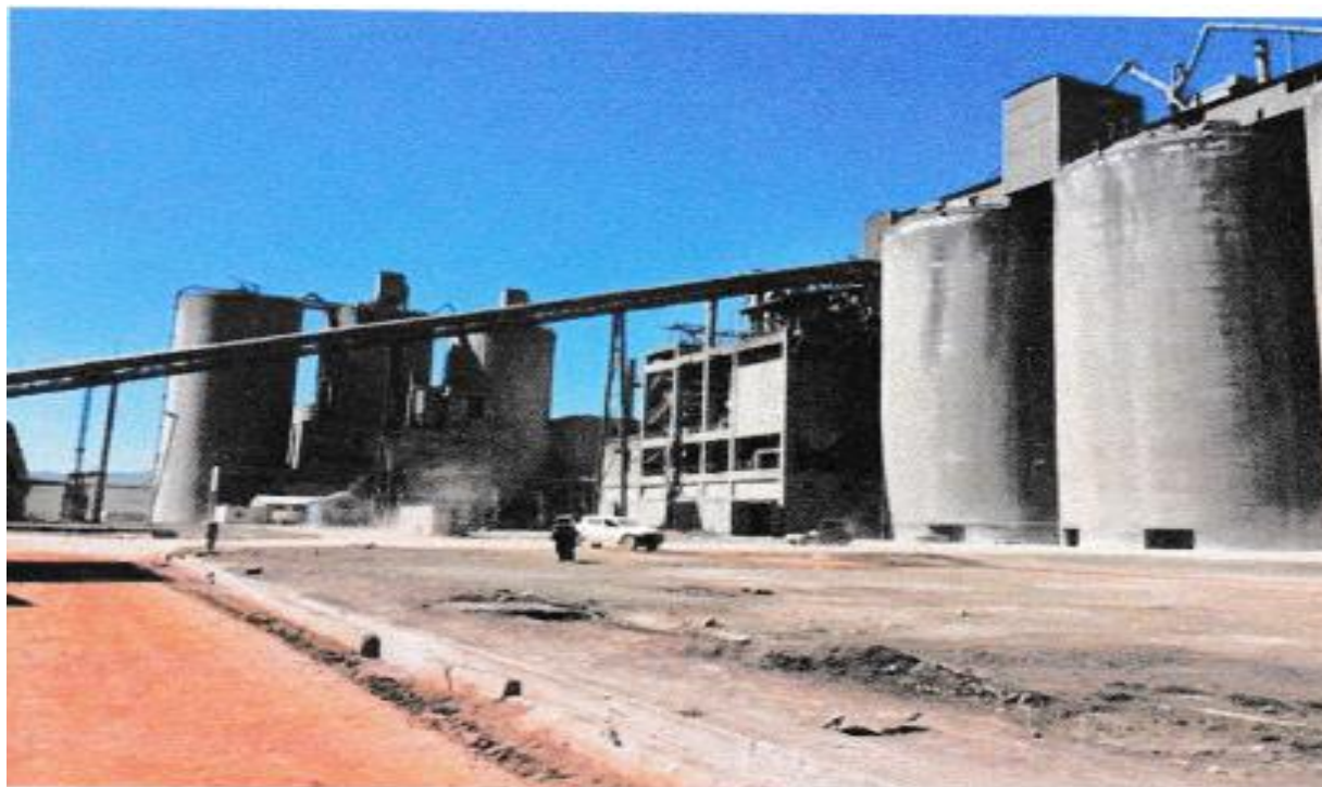
Figure I.4 : Silos de stockage.
