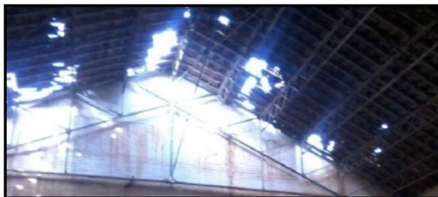
Figure 61: État de la toiture de l'intérieure de la cave<sup>280</sup>
