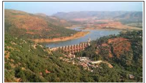
Figure20 : Le barrage de Beni Bahdel (source: http://www.radioalgerie.dz/news/fr/article/20180529/142879.html , consulté le 09/06/2020 à 03h30).
