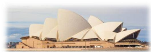
Figure 25 : Toiture d'opéra de Sydney
