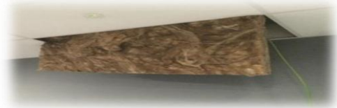
Figure 38: Les faux-plafonds absorbants en laine minérale revêtue + LM plenum
