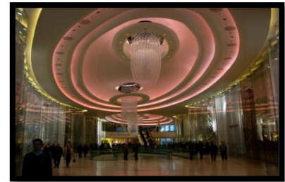
Figure 189 : Faux plafond tendu
