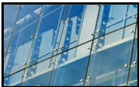
Figure 193: Mur rideaux avec spider glass
