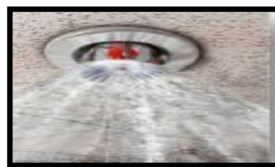
Figure 198: Extincteur automatique
