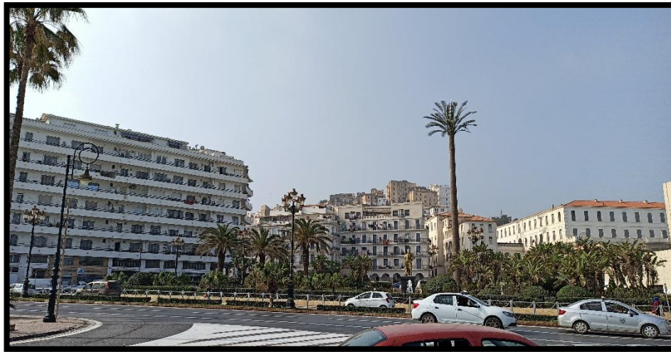
Figure 57. Vue sur l'état actuelle du site d'intervention. (Photos prises par l'auteur, Février 2020).
