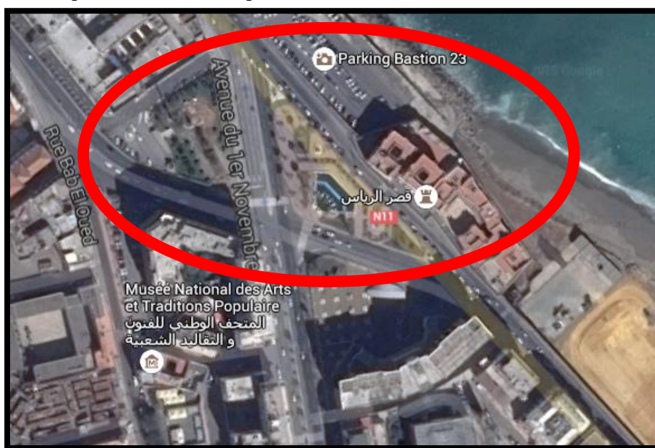
Figure 56. Situation du site d'intervention
