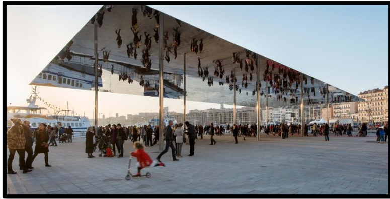
Figure 80. Pavillon du vieux port, Marseille Source: Site Web (archidaily.com), 2020
