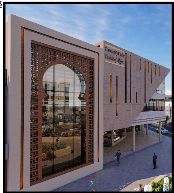
Figure 108. Panneau en céramique, façade ventilée du projet
