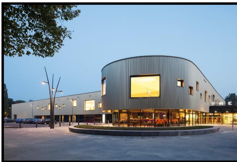
Figure 73. Vue sur le centre communautaire de Trefkoele
