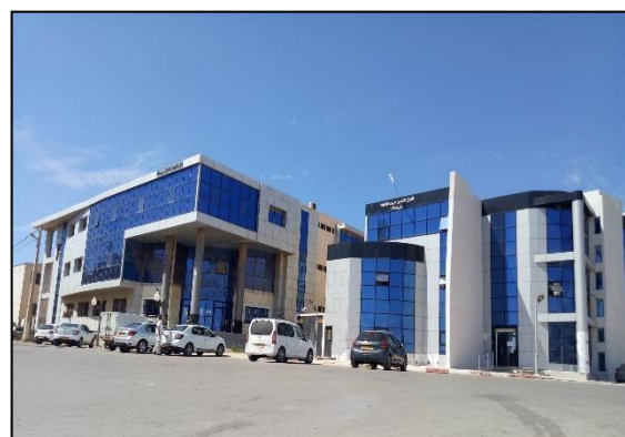
Figure 74 : Cité administrative de Beni Saf Source : Auteur
