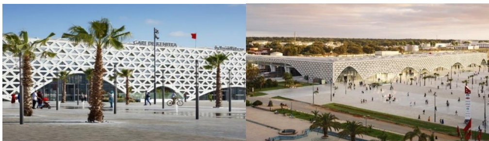
Figure 157 : La gare de Kénitra au Maroc Source : https://chroniques-architecture.com/gare-kenitra-maroc-silvio-
