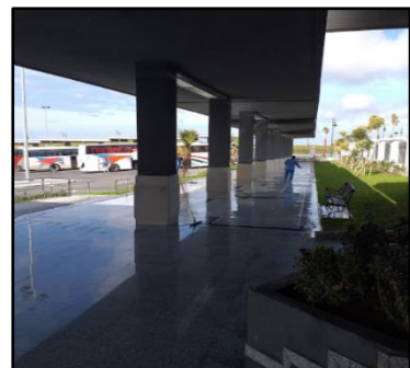
Figure 32 : Cheminement piéton au quai de bus Source : https://maroc-diplomatique.net/la-nouvelle-gare-routiere-de-tanger
