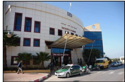
Figure 14 : Gare routière d'Ain Temouchent Source : Auteur
