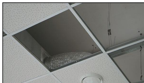
Figure 178 : Fixation faux plafond Source : https://www.monequerre.fr/faire-un-faux-plafond-techniques-de-pose-et-astuces/
