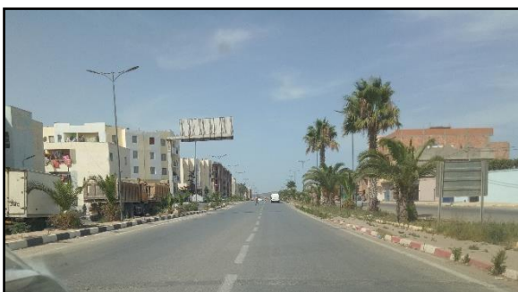
Figure 84 : Voie principale sidi Sahbi Source : Auteur
