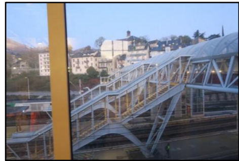
Figure 48 : Vue de la passerelle cyclo-piétonne Source : https://www.lessorsavoyard.fr
