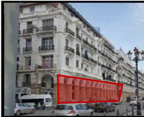
Figure 76: les arcades de la base casbah
