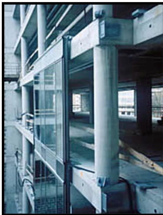
Figure 85 : Technique de montage des murs rideaux
