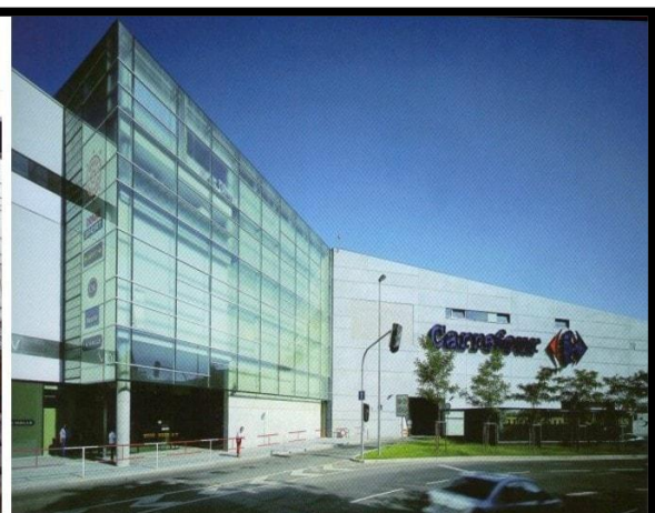
La façade secondaire
