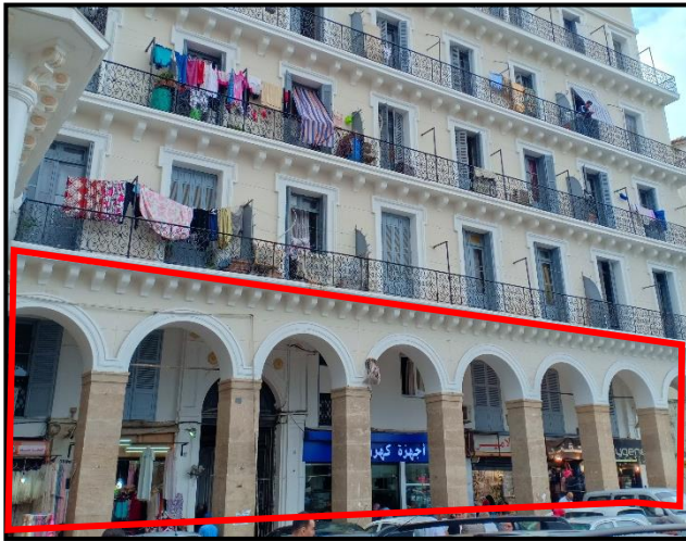
Figure 85 : Arcades commerciales, bâtiment coloniale, Source : Auteur
