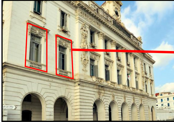
Figure 72 : Bâtiment datant de la période coloniale, fenêtre en longueur, Source : Auteur
