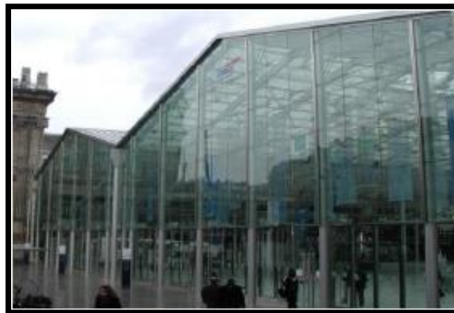
Figure 15 : Façade de nouvelle gare du Nord de paris
