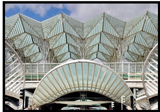
Figure 2 : Gare de Lisbonne en couverture plissée
