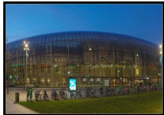
Figure 13 : l'immense verrière de la gare de Strasbourg
