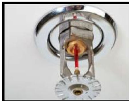
Figure 233 : Extincteur automatique à eau
