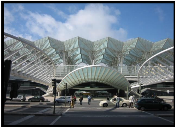
Figure 32 : Gare de Lisbonne, Portugal en structure plissée
