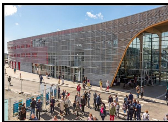
Figure 3 : La façade principale en bois de la gare de l'Orient
