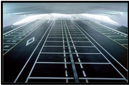
Figure 105 : Parking au RDC
