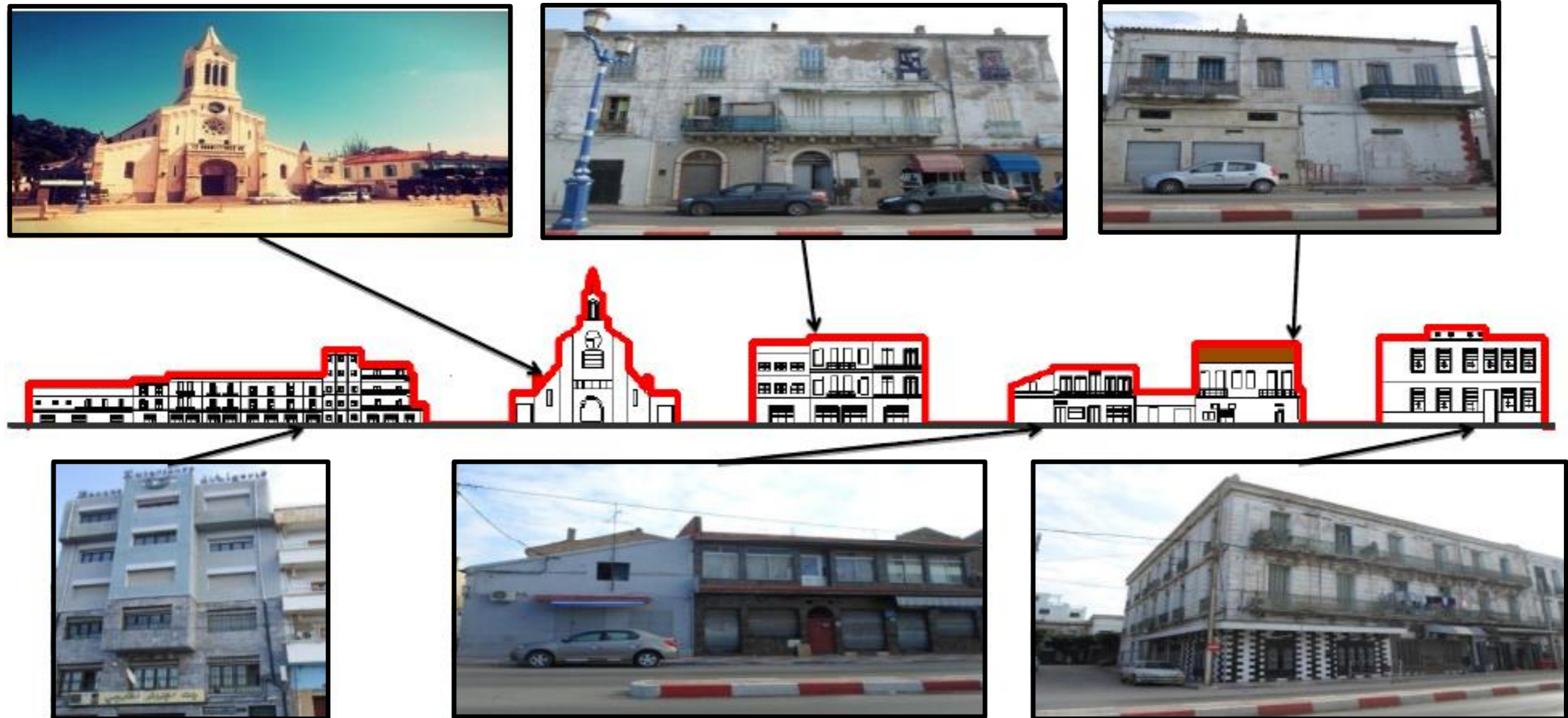
Planche 09 : Façade urbaine de la zone portuaire
