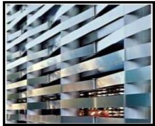
Figure 59 : L'enveloppe de la Gare de Worb, Suisse
