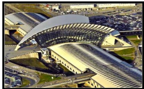
Figure 27 : Gare de Lyon-Saint-Exupéry TGV
