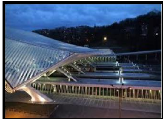
Figure 47 : Réseau d'arc qui supporte la structure de la gare
