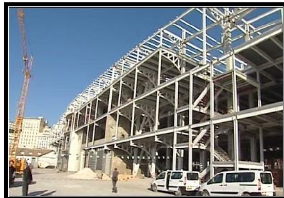
Figure 158 : Système constructif de la gare
