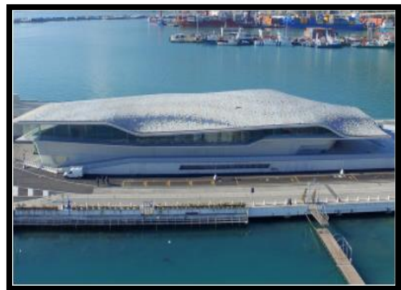
Figure 21 : Gare maritime de Salerne
