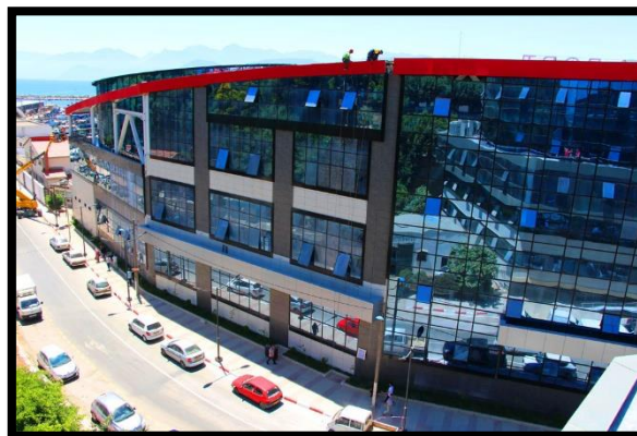
Figure 159 : Enveloppe extérieure de la gare
