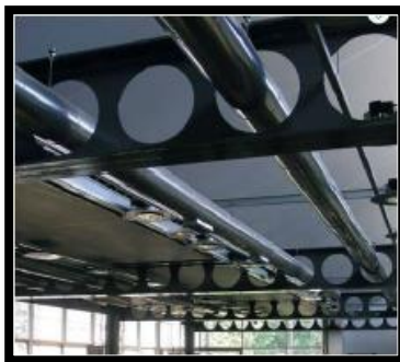
Figure 196 : Les poutres alvéolaire
