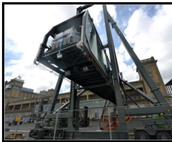
Figure 210 : vue d'une passerelle démontable
