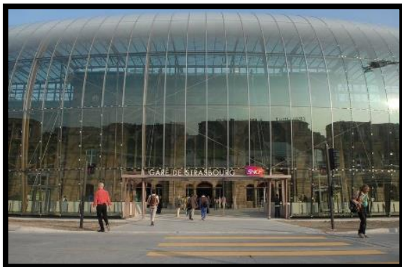
Figure 12 : vue du vitrage feuilletés sr la gare de Strasbourg
