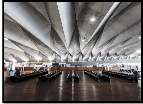
Figure 112 : Salle d'embarquement de la gare
