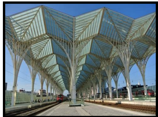
Figure 33 : couverture plissée au niveau des quais de la gare de Lisbonne, Portugal
