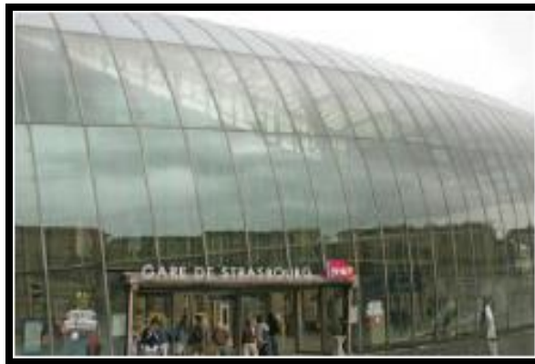
Figure 17 : La verrière de la gare de Strasbourg
