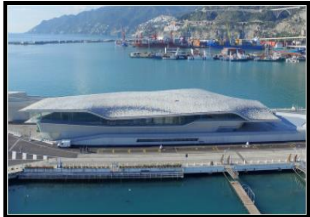
Figure 129 : enveloppe extérieure de la gare
