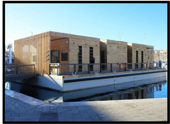
Figure 52 : L'enveloppe de terminal maritime de Marseille
