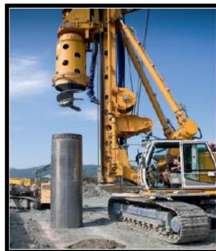
Figure 189 : Exemple de réalisation de pieux
