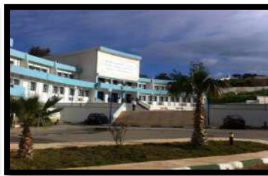
Figure 60 : Vue sur le bloc pédagogique
