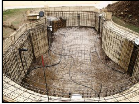
Figure 189 : Ferrailage du bassin
