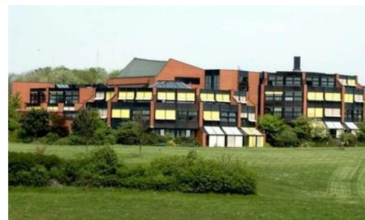
Figure 48 : façade de conservatoire
