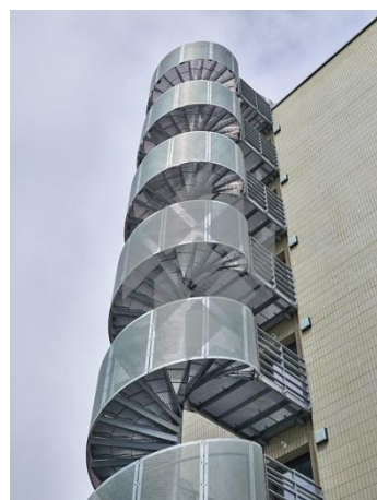
Figure 130: escaliers de sortie de secours
