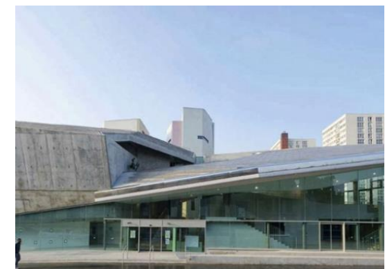
Figure 56 : façade de conservatoire
