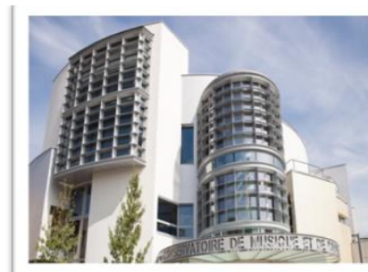
Figure 18: conservatoire de musique de Villemomble à France
