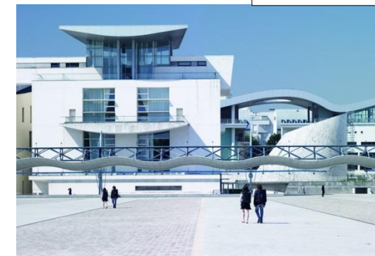
Figure 40 : façade de conservatoire
