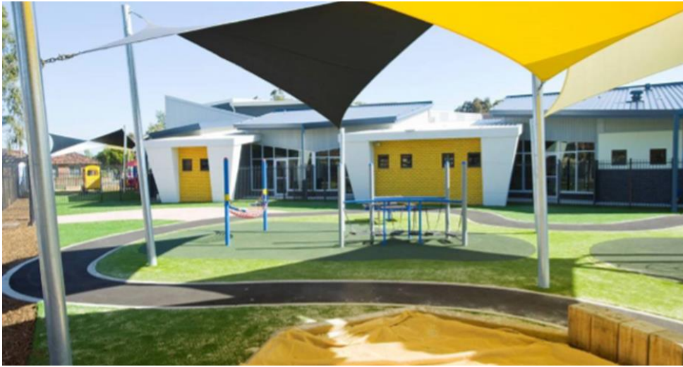
Figure 72 : façade d'après la cour
