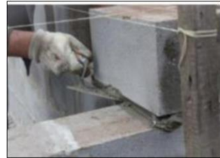
Figure 149 : cloisons en parpaings
