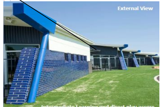
Figure 64 : vue de classe d'après la cour centrale
