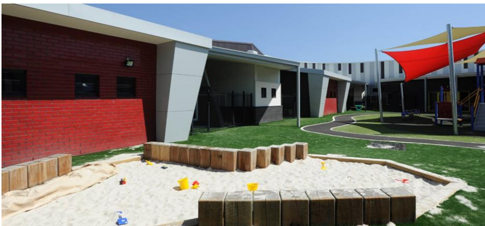
Figure 73 : façade d'après la cour
