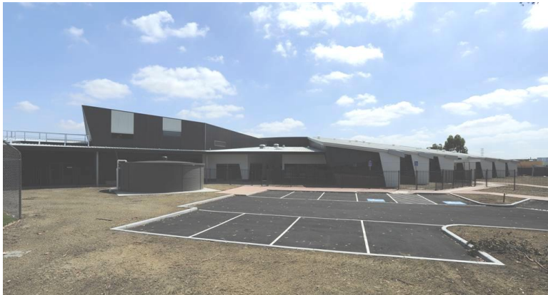
Figure 74 : vue extérieure sur la cour qui montre le systèmes de recyclages de l'eau de pluie pour les toiles
