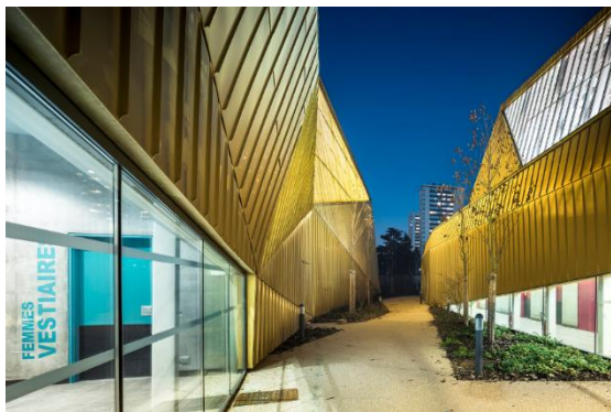
Figure 91 : Brèche centrale séparant entre les halls multisports (nuit) Source : Archdaily.com
