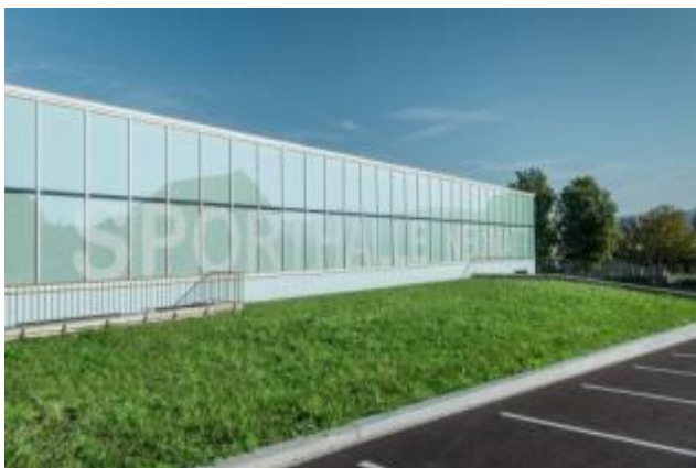
Figure 134 : Vitrage au niveau de la façade Source : Archdaily.com
