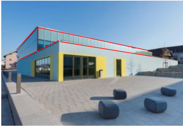
Figure 124 : Façade principale du centre Neumatt Source : Archdaily.com traitée par l'auteur
