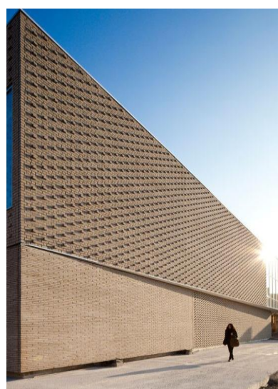
Figure 275 : Mur en brique d'Hall sportif mouvaux Source : https://www.pinterest.ca/pin/280771358003207946/
