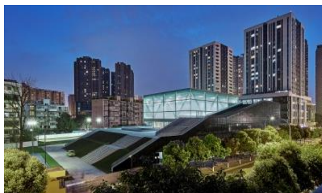
Figure 41 : façade extérieure qui montre l'inclinaison de la toiture
