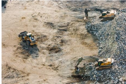
Figure 286 : Camions et engins sur chantier Source : Auteur
