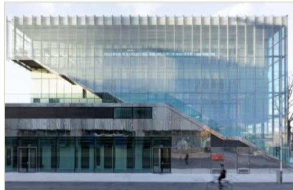
Figure 60 : Façade est du centre sportif Source : Archdaily (David Boureau photographie)
