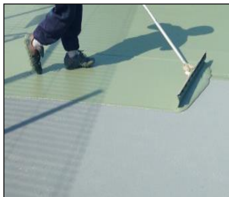
Figure 279 : fabrication du sol en résine acrylique Source : Google images
