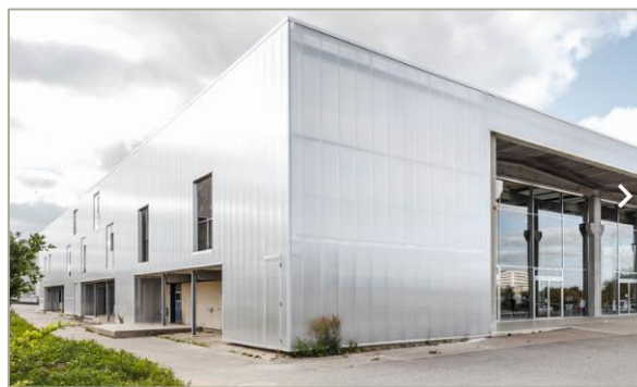
Figure 105 : nouveau bâtiment (Après) Source : https://www.oeffekt.dk/game2
