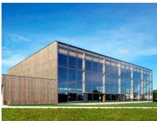
Figure 297 : Façade en triple hauteur d'Hall sportif
