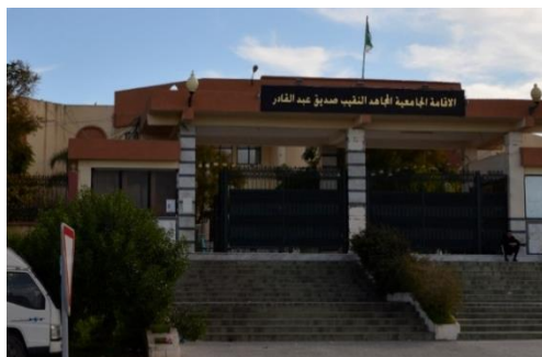
Figure 264 : Cité universitaire comme repaire urbain Source : Auteur
