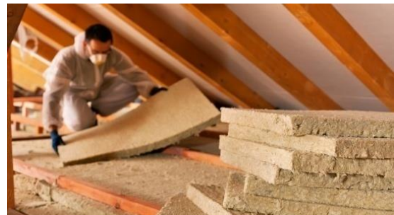
Figure 135 : laine de roche pour isolation thermique et phonique Source : Google images
