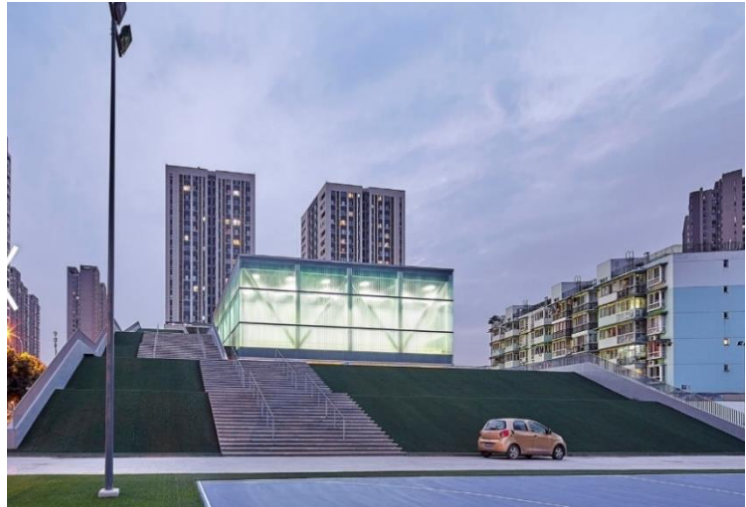
Figure 42 : façade principale montrant l'espace extérieur du centre Source : Archdaily.com
