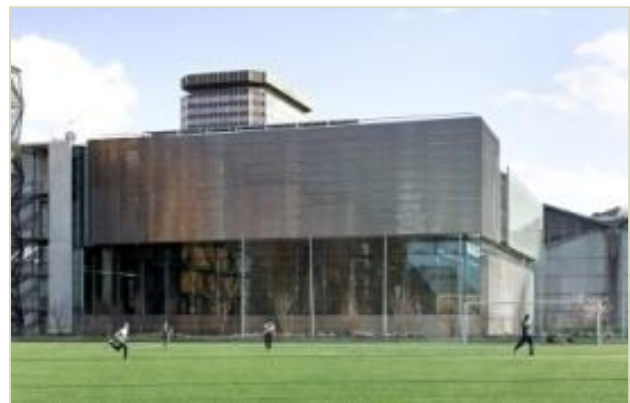
Figure 64 : façade ouest donnant sur le terrain de foot
