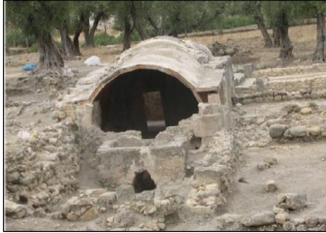
Photo 22: Le bain de Walila en 2015 après la reconstruction de la voûte. Source EL HABASHI 283
