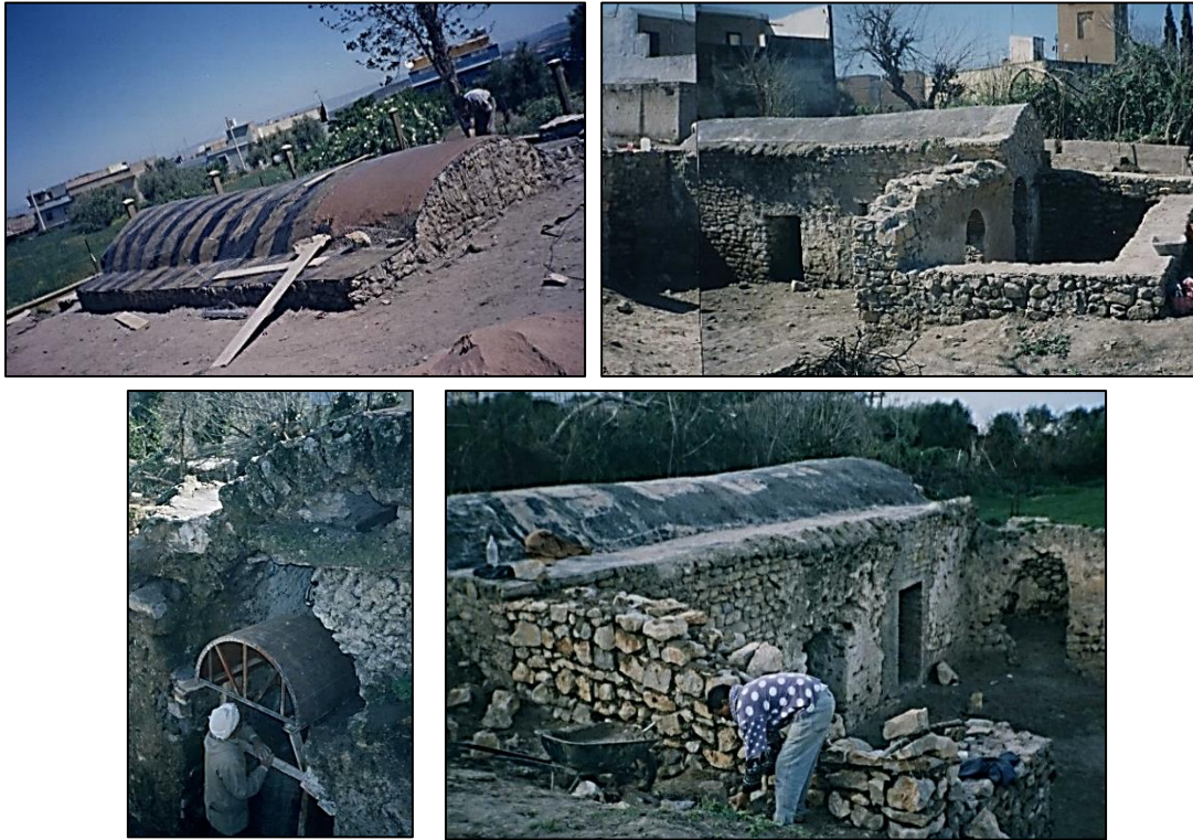
Photo 38: Le bain d'Agadir pendant les travaux de restauration. Source BET ACAT
