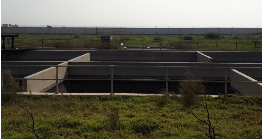
Figure III.8 : Bassin de désinfection.
