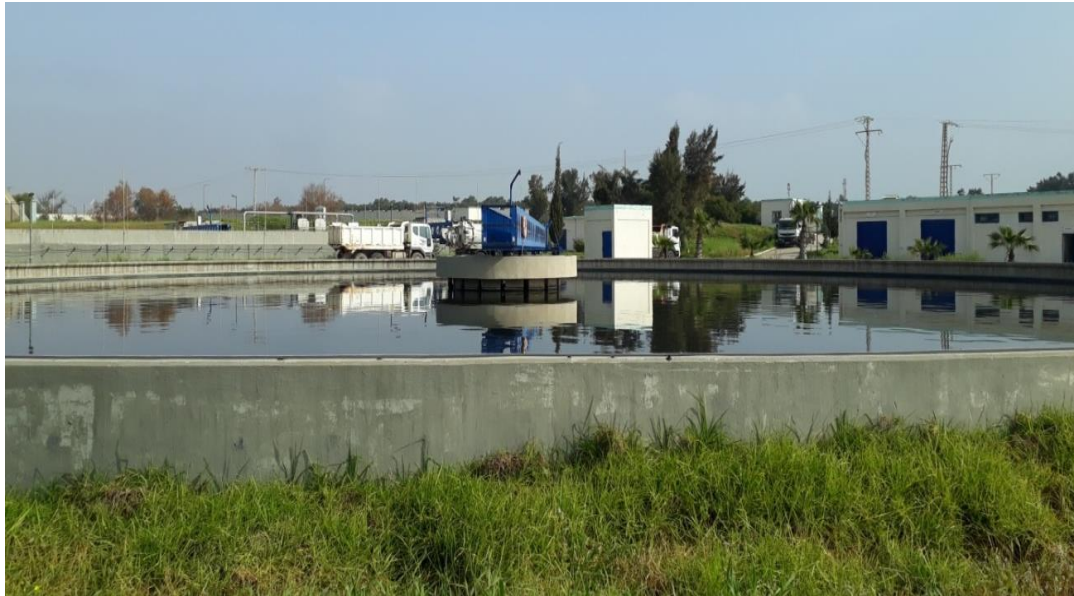
Figures III.5 : Décanteurs primaires.
