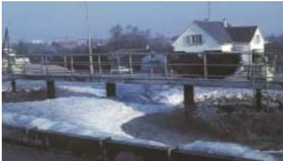
Figure I.10 : Mousse blanche de détergents en surface de bassin d'aération [18].
