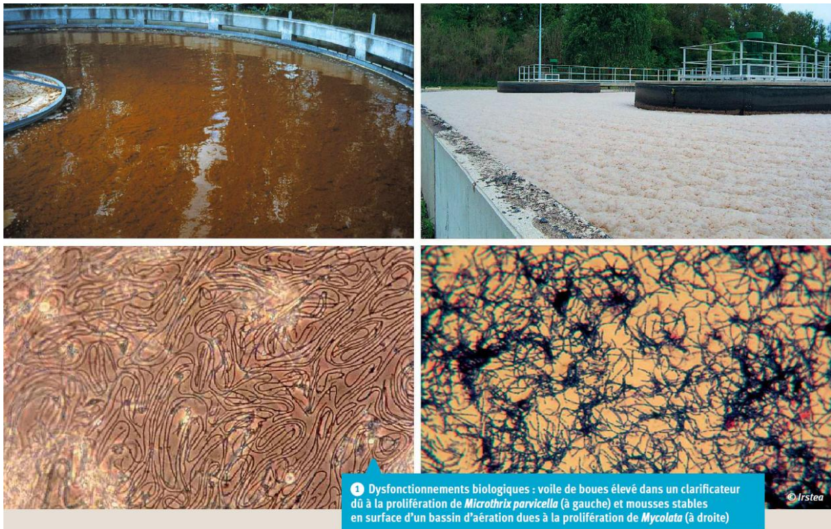
Figure I.9 : Les mousses biologiques en surface de bassin d'aération [18].
