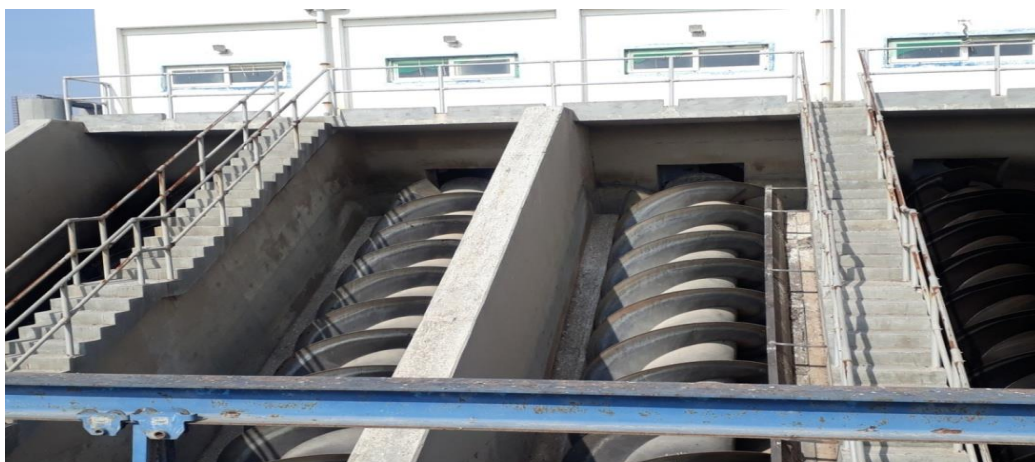
Figure III.9 : Vis d'Archimède.
