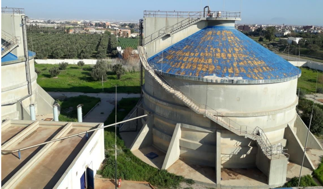
Figure III.12 : Digesteur anaérobie.
