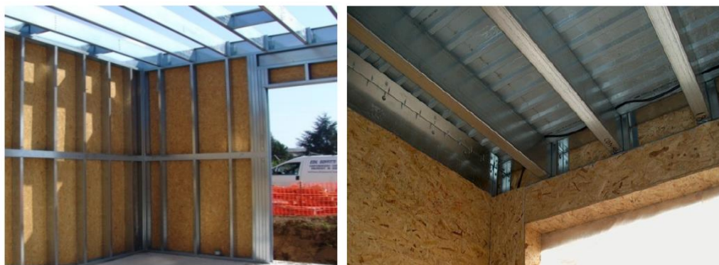
Figure 1.9 Solives de plancher en acier formées à froid
