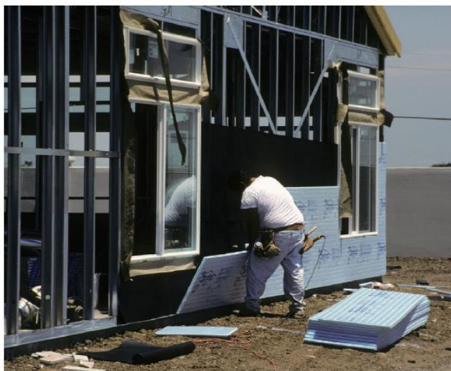
Figure 1.16 Installation de l'isolation en continu
