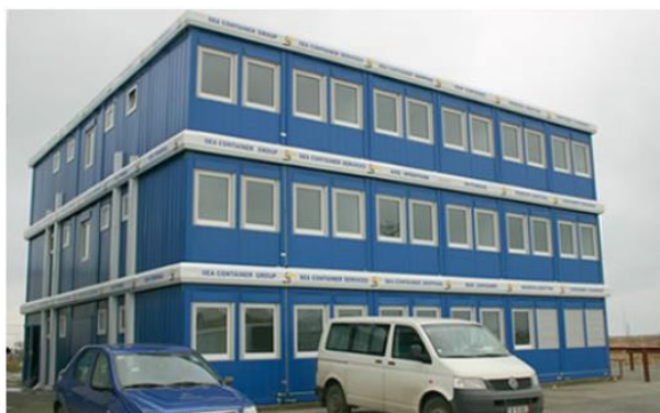
Figure 1.14 Unités modulaires préfabriquées utilisées pour les écoles et les bureaux
