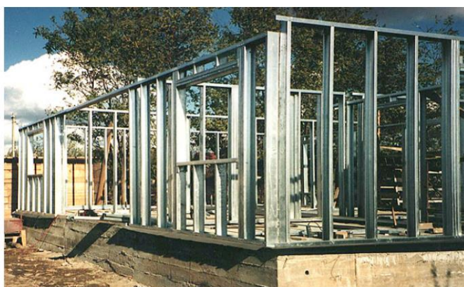
Figure 1.8 Montants de cloisons murales en acier formés à froid
