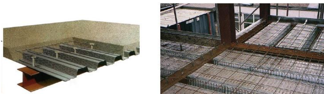
Figure 1.11 Planchers mixtes (acier-béton)
