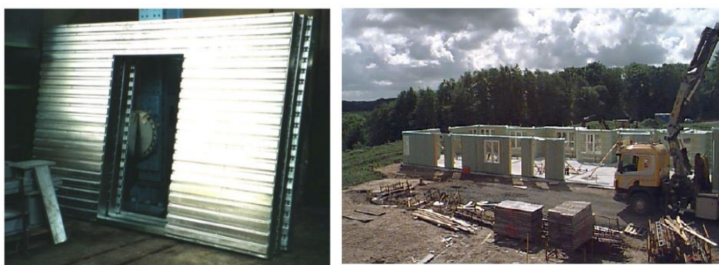
Figure 1.10 Panneaux muraux en profilés d'acier formés à froid
