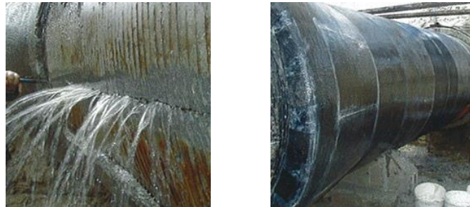
Figure 1.14 Réparation des conduites par matériaux composites [(Fibrwrap, 2012)]
