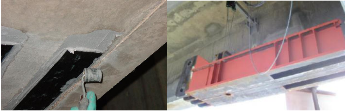
Figure 3.1 Renforcements des structures par des plaques en FRP
