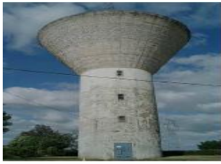
L'eau de réservoir
