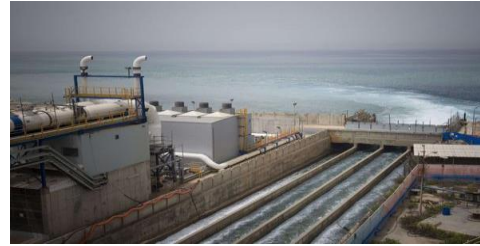
Station de dessalement de l'eau
