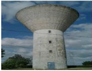
Château d'eau (réservoir)
