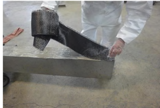
Mise en place manuellement le tissu composite
