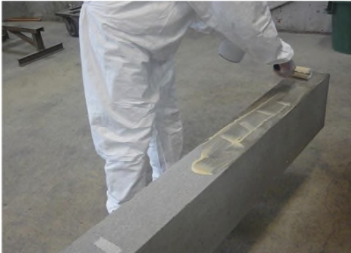
Première couche de la résine appliquée sur la surface tendue de la poutre
