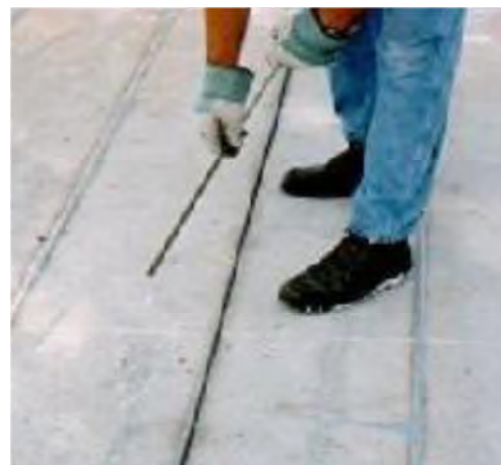
Insertion des jons de carbone par la technique NSM
