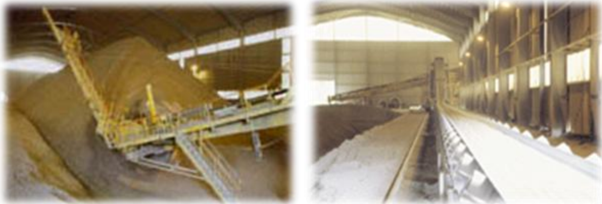
Figure 1.9. Préparation et pré-homogénéisation du mélange [4].
