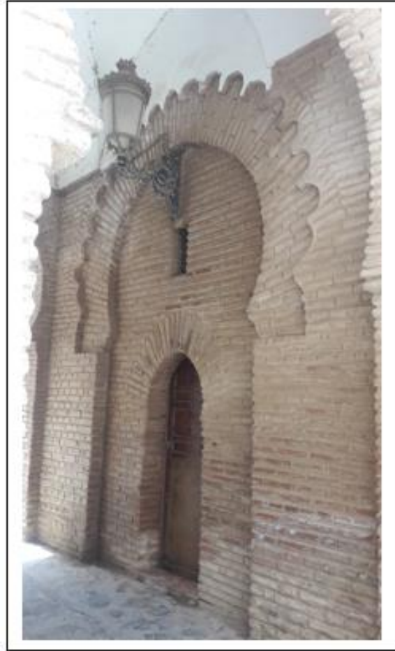
الصورة (10): المدخل الثانوي للمدرسة، تصوير الطالبة.
