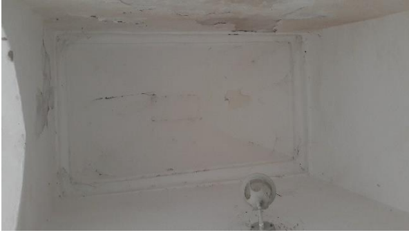
الصورة (21): أتمودج للقبو الهرمي مقطوع التّهاية الحادة، المستخدم في أسقف المعلم، تصوير الطّالبة.
