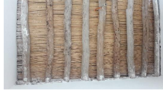
الصورة (22): السّقف التّقليدي المنبسط، المستخدم في تغطية إحدى حجرات الإيواء في الطّابق الأرضي؛ الطّالبة.
