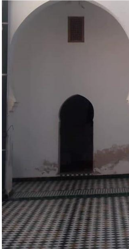
الصورة (14): منظر تفصيلي لواجهة حجرات الإيواء، تصوير الطالبة.
