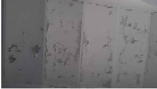
الصورة (23): تقنية التّسقيف بالعوارض المعدنية والأجر المصمت المعاصرين في الطّابق الأرضي، تصوير الطّالبة.
