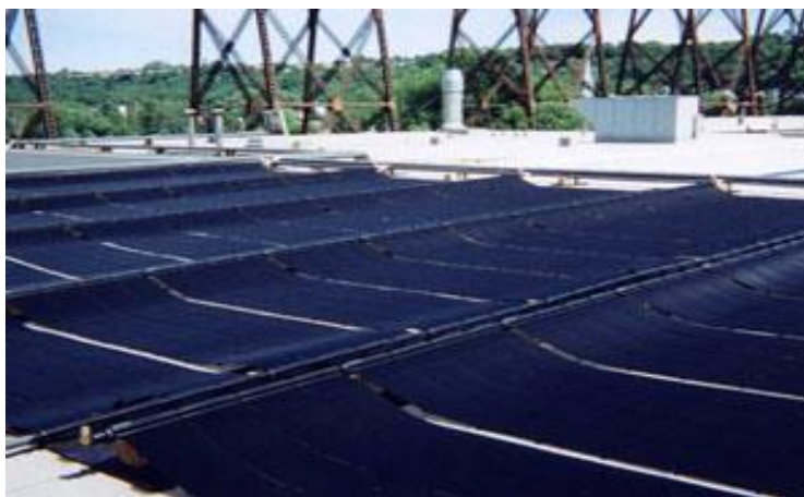
Fig 3.3 Capteurs solaires plans sans vitrage [34]
