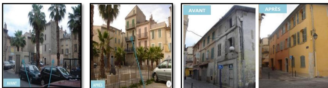
Figure 13 : avant démolition de l'immeuble réhabilitation des logement Maison de l'habitat avant et après intervention
