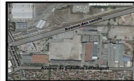
Figure :vue aérienne du site de Tase
