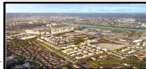
Figure : vue d'ensemble sur quartier yoplait et tase
