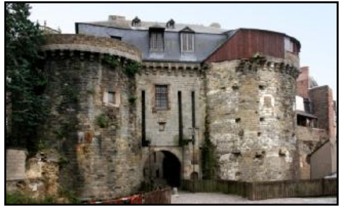
Figure 81: Vue de la porte avant l'intervention, Source: www.presse.metropole.rennes.fr
