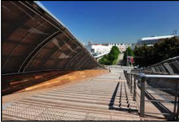
Figure 165: Début de l'accès à la passerelle, Source: http://news.construiracier.fr
