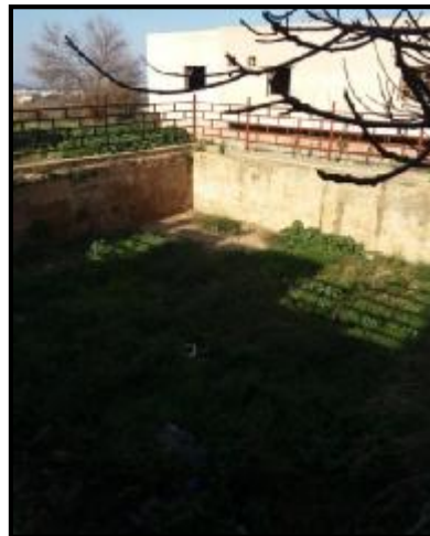
Figure 26: Bassin en pisé, source: prise par l'auteur
