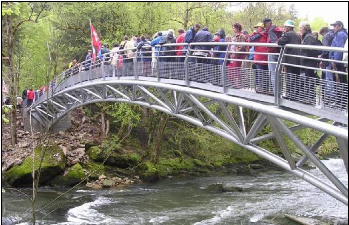
Figure 164: Poutre métallique tridimensionnelle supportant le tablier de la passerelle, Source: https://www.rtn.ch/Scripts/Index.aspx?id=2516114
