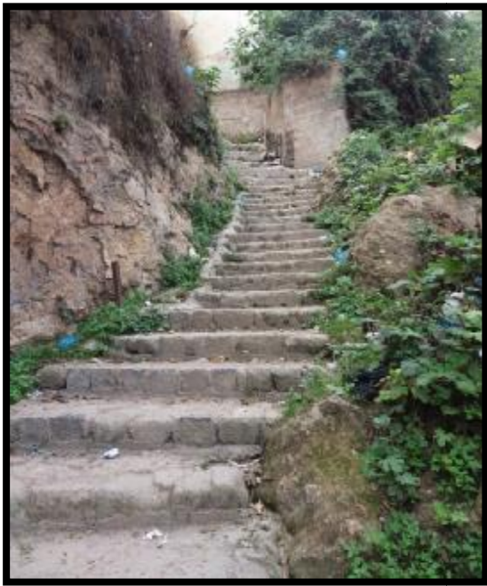
Figure 50: Escalier piéton Nord, Source: prise par l'auteur
