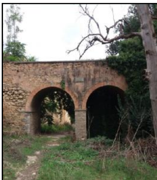
Figure 24: Le pont en pierre, Source: prise par l'auteur
