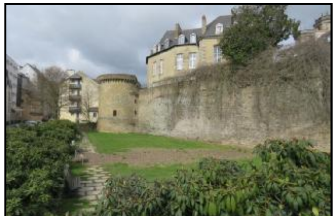
Figure 80: Mur d'enceinte avant l'intervention, Source: www.presse.metropole.rennes.fr
