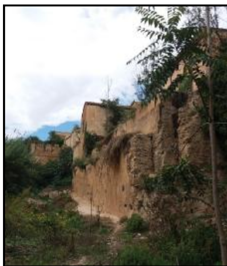
Figure 32: Muraille Sud, Source: l'auteur
