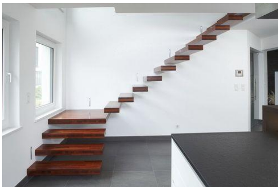
Figure 49 : Escalier à quart tournant.
