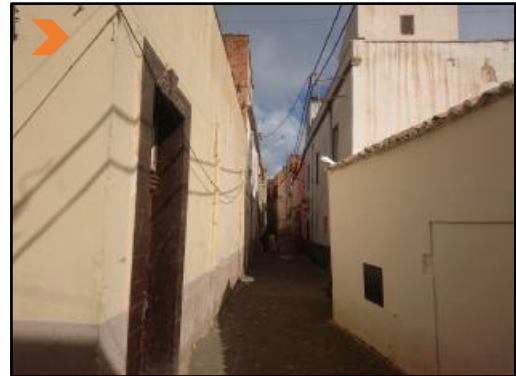
Figure 39 : prise de vue N°2 depuis la rue BOUABDELLAH Source : auteurs
