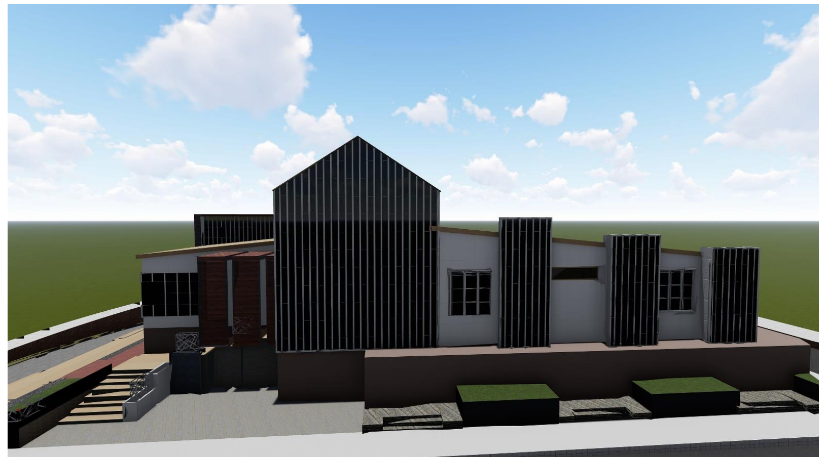
Façade latérale salle de Dojo
