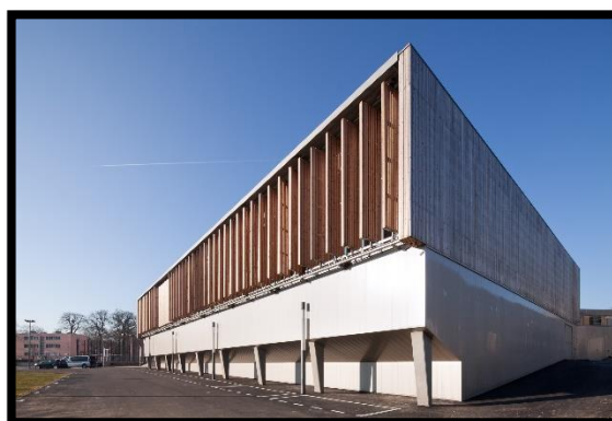
Figure 28: Complexe sportif Léonard de Vinci à Châtenay-Malabry
