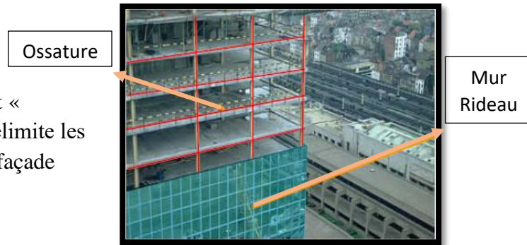
Figure 116 : composition d'une façade a mur rideau
