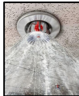
Figure 330 : Tête Sprinkler
