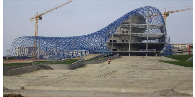
Figure 53 : Coque de forme libre
