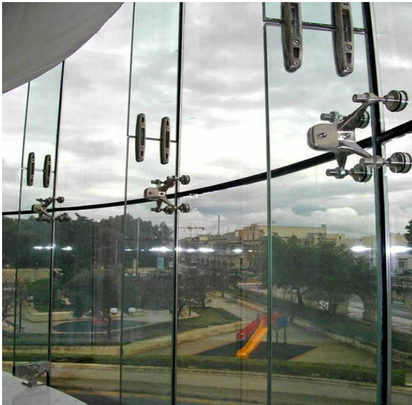
Figure 292 façade en VEA
