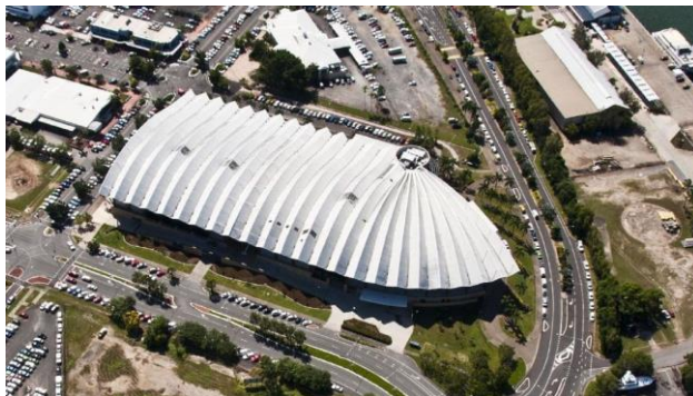
Figure 64 : Toiture Plissée, Palais des congrès Cairns
