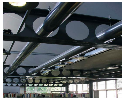
Figure 252 : passage des gains dans Poutre alvéolaire
