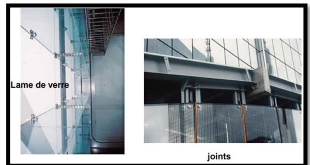
Figure 130 : La liaison entre les panneaux vitrés et les joints
