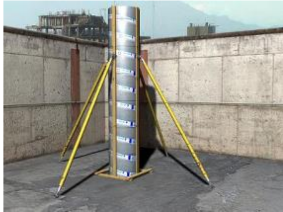
Figure 247 : Coffrage du poteau
