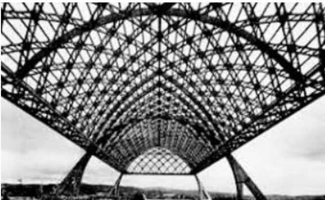
Figure 250 : Poutres en treillis spatial
