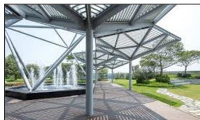
Figure 42: structure en parapluie inversé, source : www.archdaily.com
