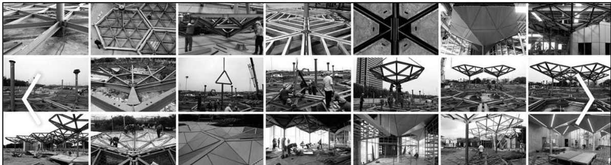
Figure 58: la mise en place du module parapluie sur la colonne
