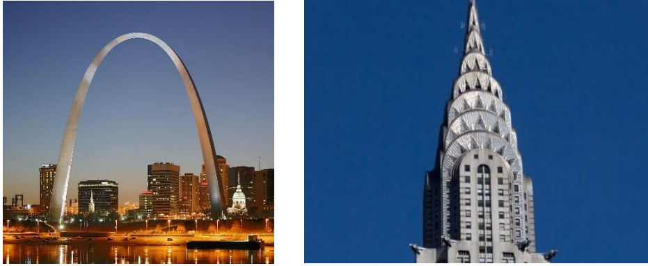
Figure 71 : Utilisation de l'acier inoxydable dans le Chrysler building et le Mississippi arch
