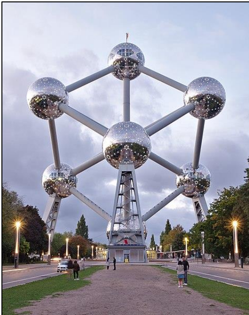
Figure 47: Vue d'extérieure; Atomium.
