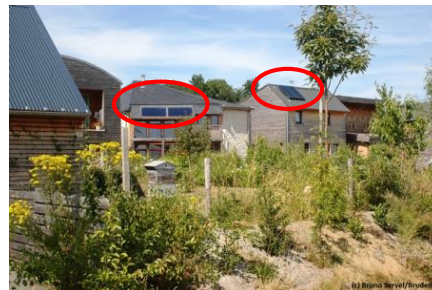
Figure 98. Les panneaux solaires intégrés au bâti (source : Évaluation nationale de l'éco-quartier de Bazouges-sous-Hédé, pp 01).
