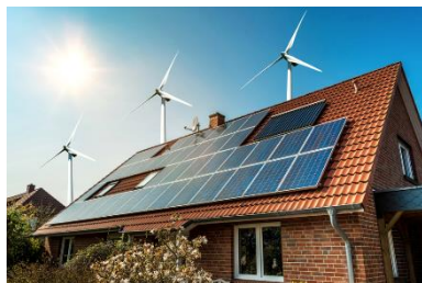
Figure 31. Panneaux photovoltaïques (source : https://www.lecomparateurassurance.com/6-actualites-assurance/109350-qu-est-qu-maison-autonome , consulté le 27/12/2018 à 10h46)
