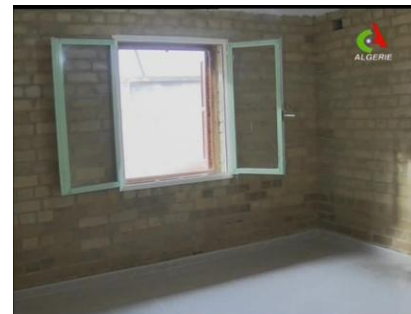
Figure 63. Ouverture sud en double vitrage (source : Bourafa I (2012), p235)
