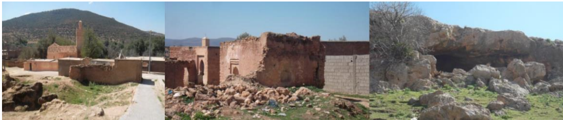
Figure 133. Ancienne mosquée, habitat vernaculaire, habitat troglodyte (source : les auteurs).
