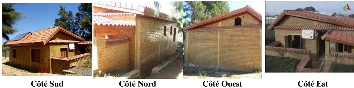
Figure 62. Les 4 façades de l'habitation (source : CNERIB 2014)
