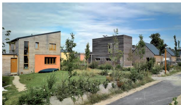
Figure 95. Diversité de formes architecturales (source : Hédé-Bazouges, Ille-et-Vilaine, pp 20).
