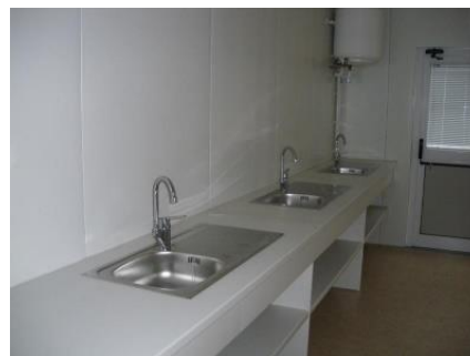
Figure 153. Un évier de cuisine (source : http://www.bcm.fr/paillasse-cuisine , consulté le 08/06/2019 à 20h29).
