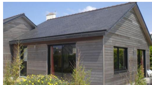
Figure 88. Façade en bois et toiture en ardoise (source : Éco-lotissement les Fages, pp 24)
