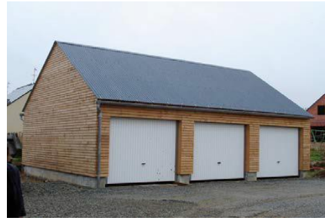
Figure 77. Couverture en ardoise et des garages en bac acier (source : Eco-Quartiers en Ille-et-Vilaine TERRITOIRES en PROJETS 2013, pp 09)
