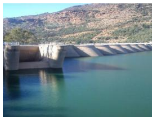
Figure 129. Le barrage de Beni Bahdel (source : http://www.radioalgerie.dz/news/fr/article/20180529/142879.html , consulté le 09/12/2018 à 14h54).
