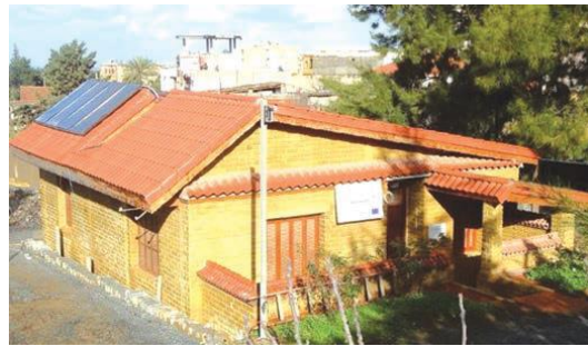
Figure 58. Projet pilote de Souidania (source : Revues de Presse, Ouverture à Alger de la réunion du Forum international de l'énergie, pp26)
