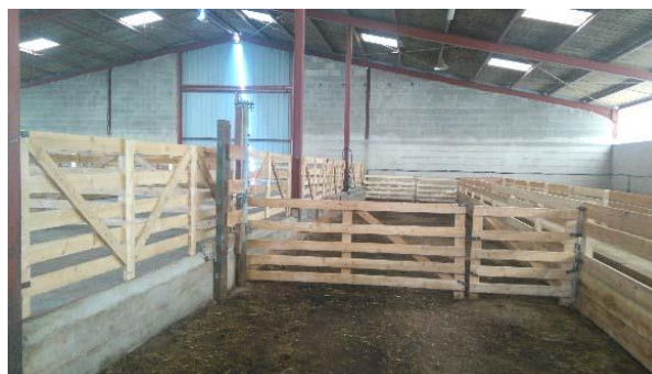
Figure 192. Sol de la bergerie en terre traitée (source : https://docplayer.fr/43895538-Une-bergerie-amenagee-dans-une-ancienne-stabulation-pour-vaches-laitieres.html , consulté le 15/05/2019 à 20h02).
