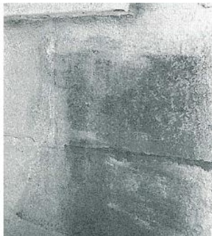
Figure 281. Le nettoyage à l'eau (source : Guide technique 6, la maçonnerie de pierre, maître d'œuvre « ville de Québec », pp 13).
