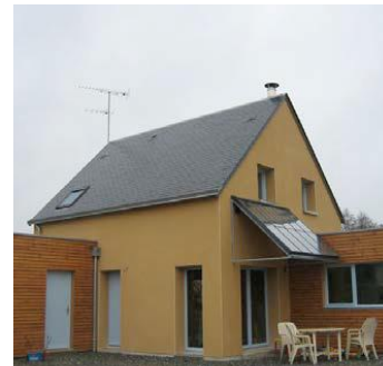
Figure 79. Les panneaux solaires thermiques (source : Eco-Quartiers en Ille-et-Vilaine, pp 11)
