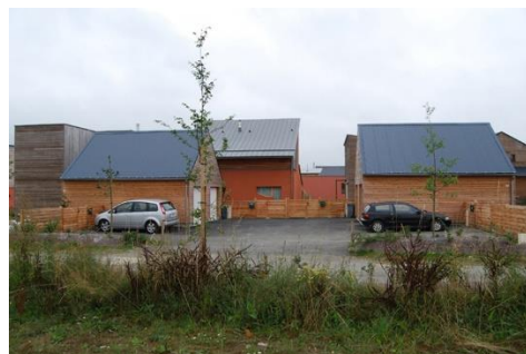
Figure 94. Garages privatifs groupés (source : http://www.menguyarchitectes.fr/urbanisme/nouveaux-quartiers-et-lotissements/bazouges-sous-hede-ecolotissement/ , consulté le 04/03/2019 à 07h32).
