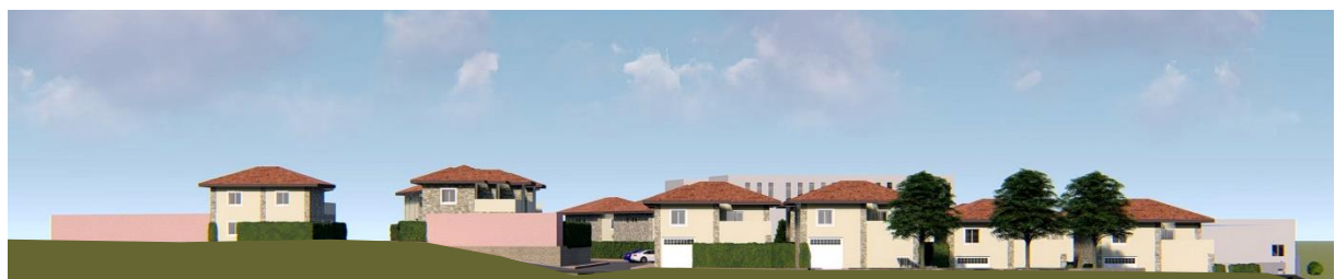
Figure 329. Façade Ouest des habitations (source : les auteurs).
