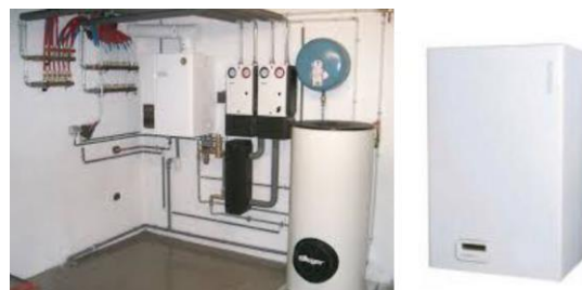
Figure 233. Chaudière muraille à gaz
