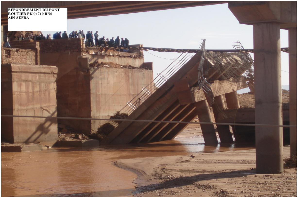
**Photo I.11: effondrement du pont routier à PK 0+710 RN6 –Ain Sefra**
