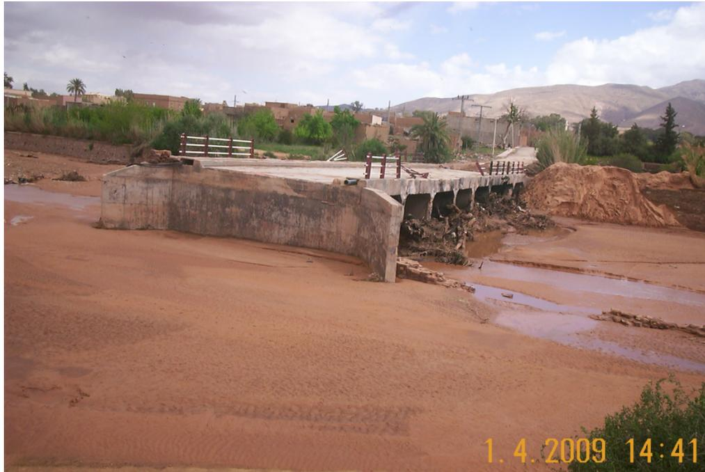
**Photo I.10: Affouillement des remblais d'accès d'un dalot en Algérie (Accumulation des débris et réduction de la section d'écoulement).**
