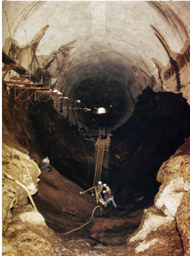
**Photo I.7 : Les dommages dans le tunnel d'évacuation de barrage Glen Canyon**
