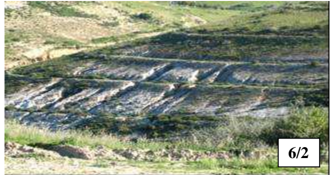
RUPTURE DE BANQUETTE --- RAVINEMENT
