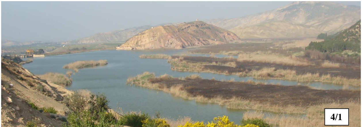
ENVASEMENT DE BARRAGE – BARRAGE DE FERGOUG (PLUS DE 90% D'ENVASEMENT)
