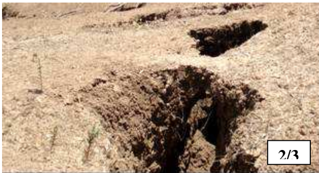
EROSION EN SUFFOSION
