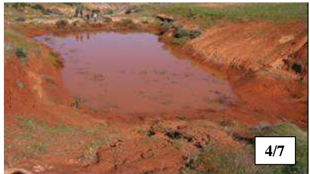
ENVASEMENT DES DIGUETTES
