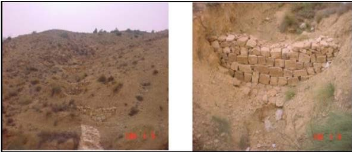
Figure 1.14 : Correction torrentielle (Benmechernane N., 2013).
