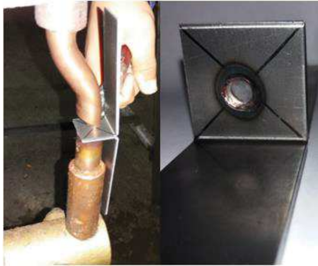
Figure II.11 Opération de soudage.
