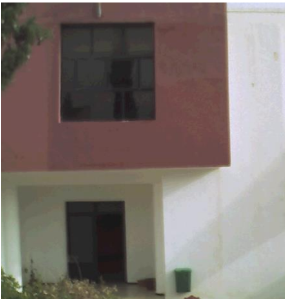
Figure 3.40 : Image réelle d'une paroi
