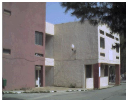
Figure 3.23 : Image réelle d’un mur dans l’administration
