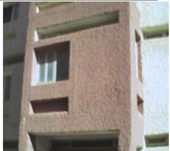
Figure 3.37 : Image réelle d’un mur dans le bloc A
