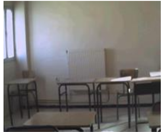
Figure 3.35 : Image réelle d'un mur dans le bloc A
