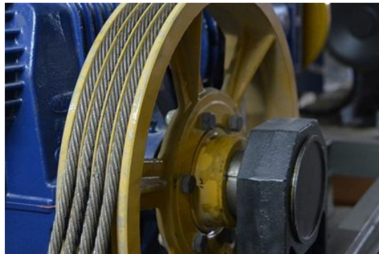
Figure 3.12 : Poulie et câble de traction ascenseur
