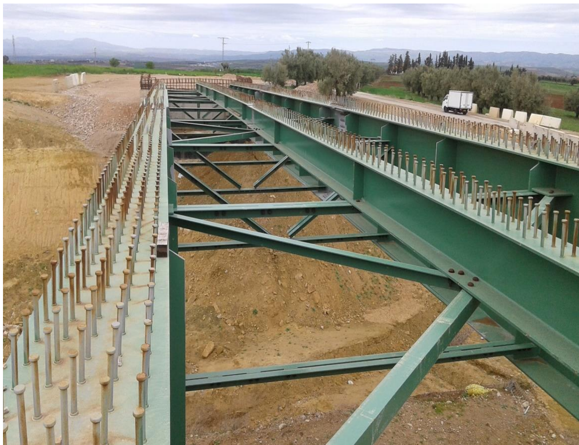
Figure 1-15 : Connecteurs de type goujons (5)
