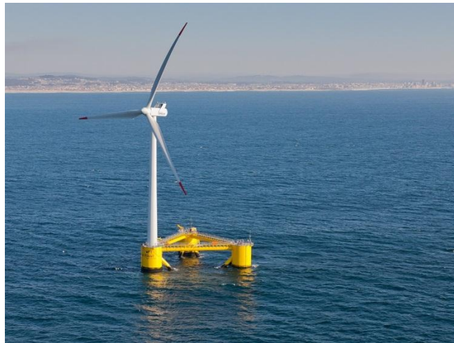
Figure. 1.6 : Eolienne avec structure immergée en mer (MERETMARINE).
