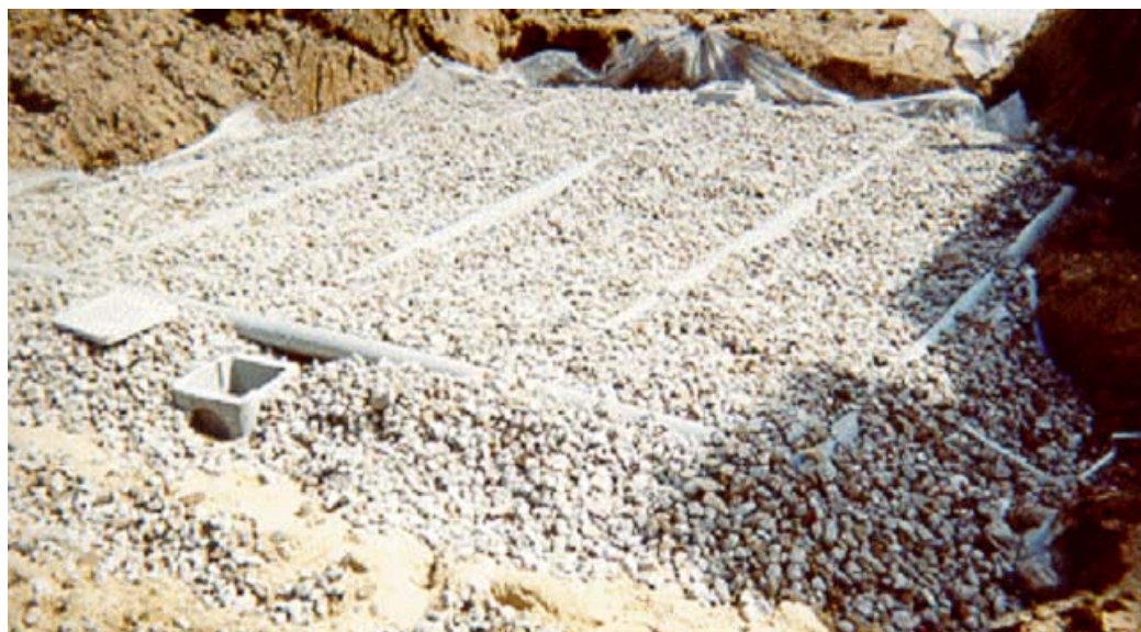
Figure 0.14: Pose de drains, gabions d'évacuation pour un à écoulement vertical [45].
