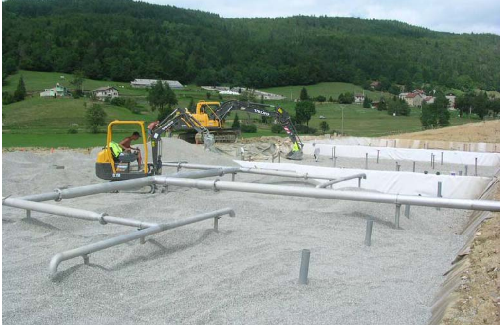
Figure 1.7: Pose d'une couche de gravier d'un bassin à écoulement vertical.
