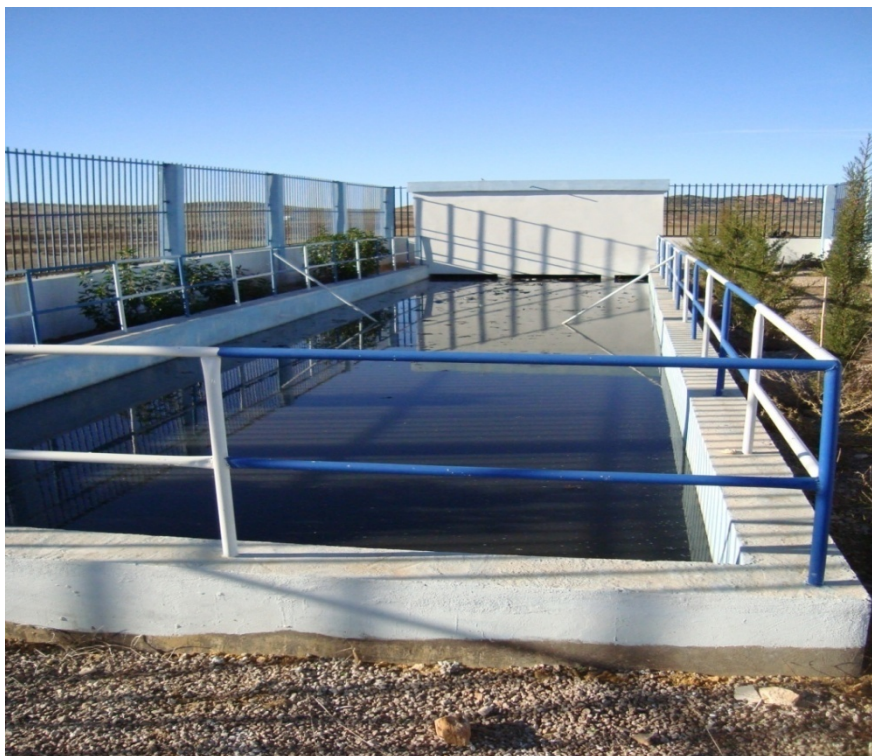
Figure 0.40: Le bassin de décantation Terny.
