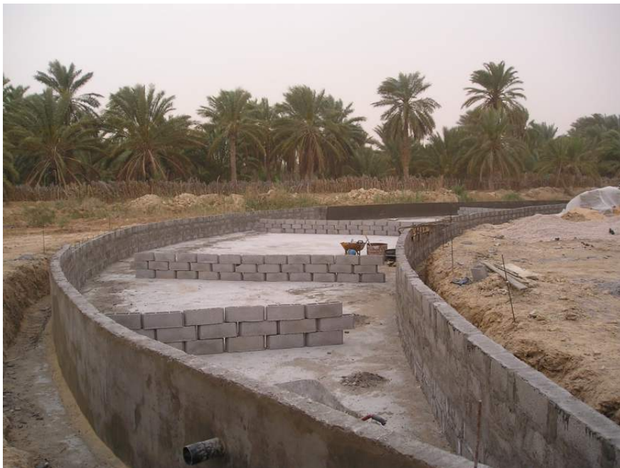
Figure A. 4: Photo prise lors de la réalisation du bassin de traitement.
