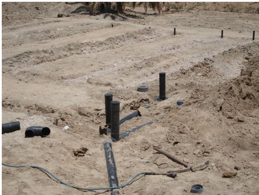
Figure A. 6: Photo prise lors de la réalisation du réseau de drainage des eaux pour l'irrigation des arbustes.
