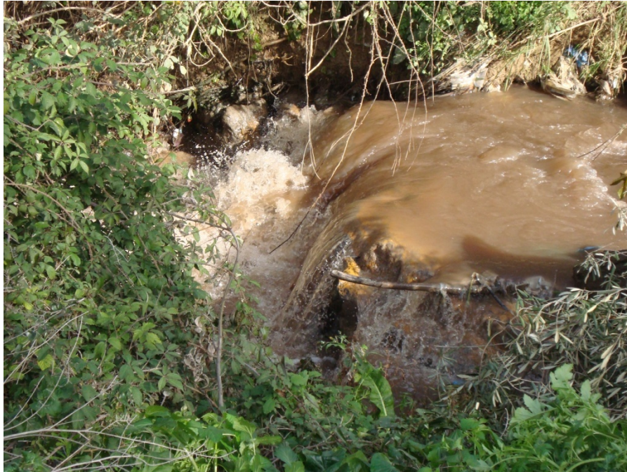
Figure 0.18: Fin du caniveau des points de rejet R25 et R24 d'Ain Bendou.
