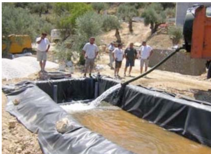
Figure 0.22: Essai d'étanchéité du bassin avant le remplissage des couches filtrantes [97].
