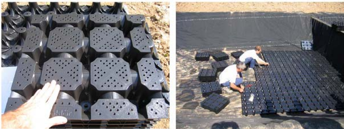
Figure 0.13: Photo de la mise en place d'un planché aérant pour un filtre à écoulement vertical [65].
