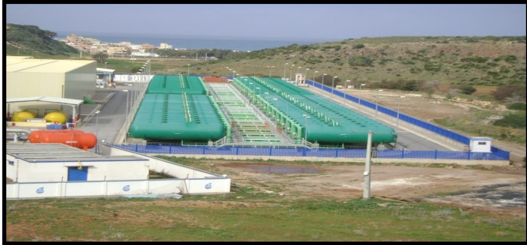
Figure IV. 5 : Filtres à sables et anthracites [57].
