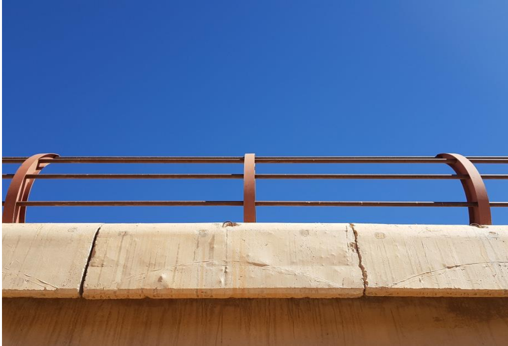
Figure VIII.3 : Dispositif de retenue et corniche du pk 7 Mecheria
