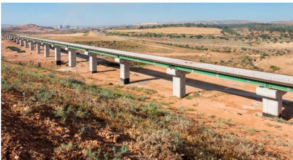
Figure II-2 : Le pont existant vue de loin
