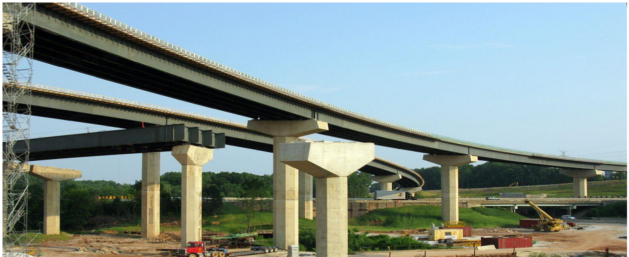
Figure I-11 : Ponts mixtes multi poutres, Baltimore (États-Unis)
