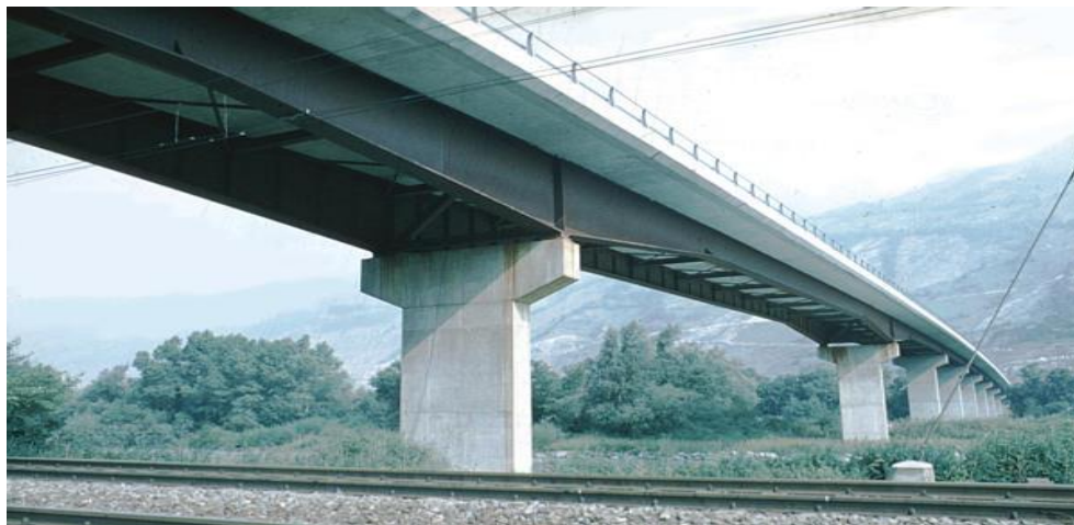
Figure I-13 : Exemple d'un pont mixte bipoutre
