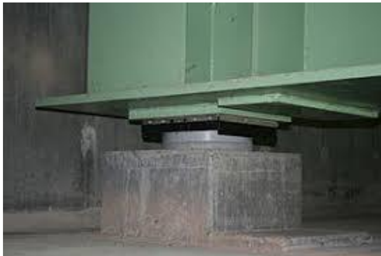
Figure VI-1 : photo réelle d'un appareil d'appuis
