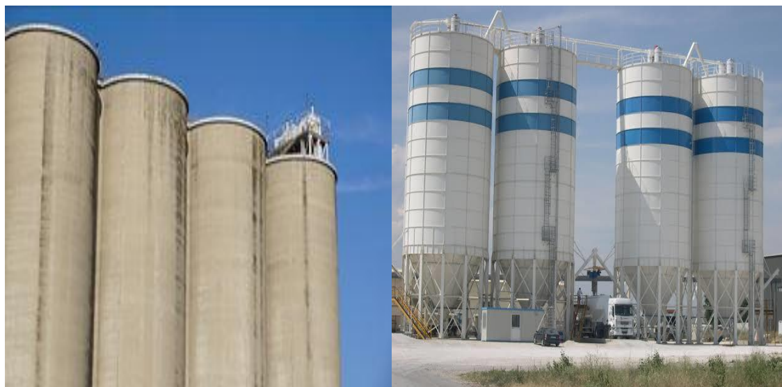
Figure I.14 : Silos de stockage du ciment.
