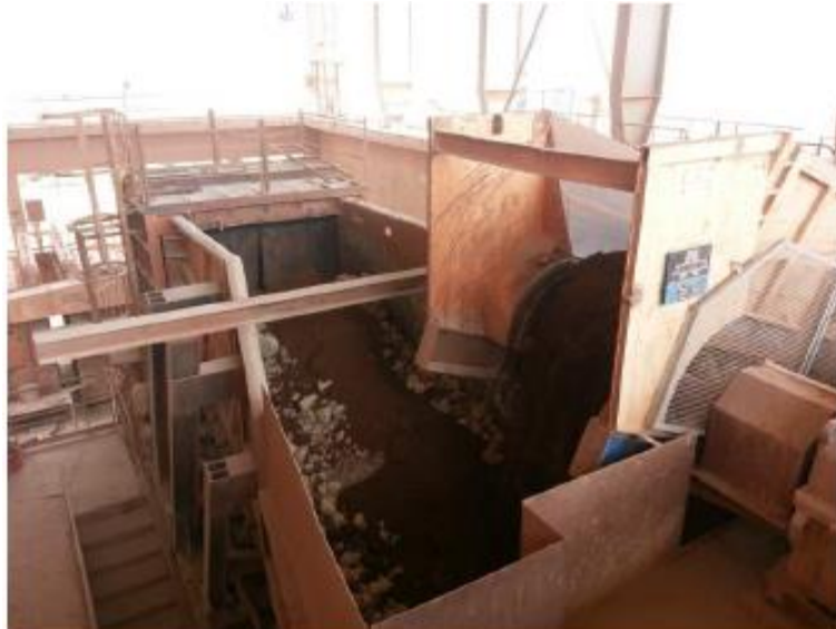
Figure I.11 : Concassage des matières premières au niveau de la carrière.
