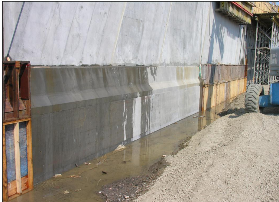
Figure I.3 : Glissière ancrée après le décoffrage (Québec) [Nadia Pouliot, 2013]
