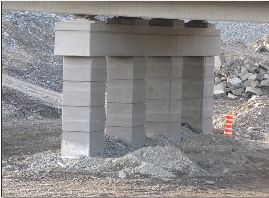
Figure I.2 : la pile centrale après bétonnage (Sherbrooke) [Olivier Bonneau, 2011]
